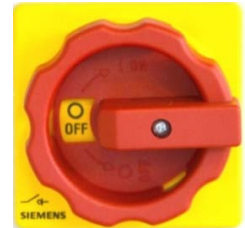
Abbildung 10: Hauptschalter der Gasdetektionsanlage (10) (Position OFF)
