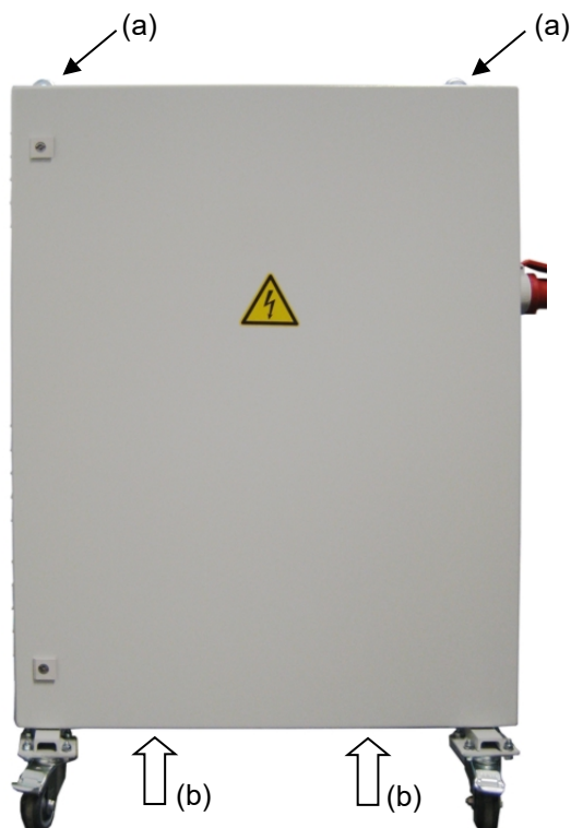
Abbildung 18: Positionierung von Hilfsmitteln zum Anheben des Spannungs- und Frequenzumwandlers
