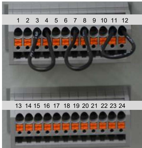
Abbildung 23: Klemmenbelegung
